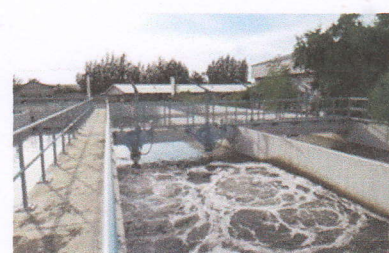
บ่อบำบัดน้ำเสีย
